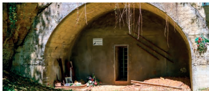
Entrée du tunnel
