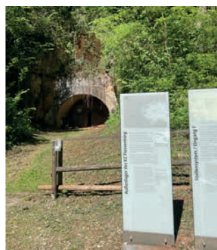
Entrée du tunnel
