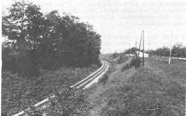
Kaplice, la tranchée où le train a été arrêté.
