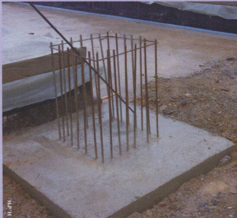
Fondation d'une des deux colonnes en béton pour marquer la porte d'entrée.
